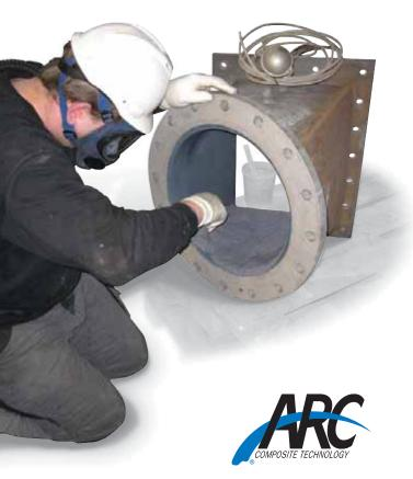
Notre gamme de revêtements de resurfaçage à couche mince d'excellente tenue s'appuie sur des résines époxy et uréthane, à teneur en solides de 100 %, renforcées de particules de céramique pour la résistance aux conditions érosives et abrasives.
